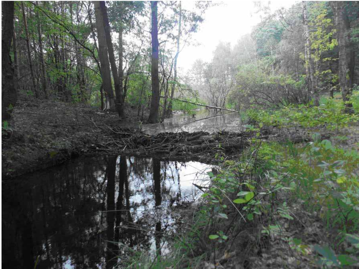
Neubau Biberdamm (ca. 10 m oberhalb des provisorischen Damms)
